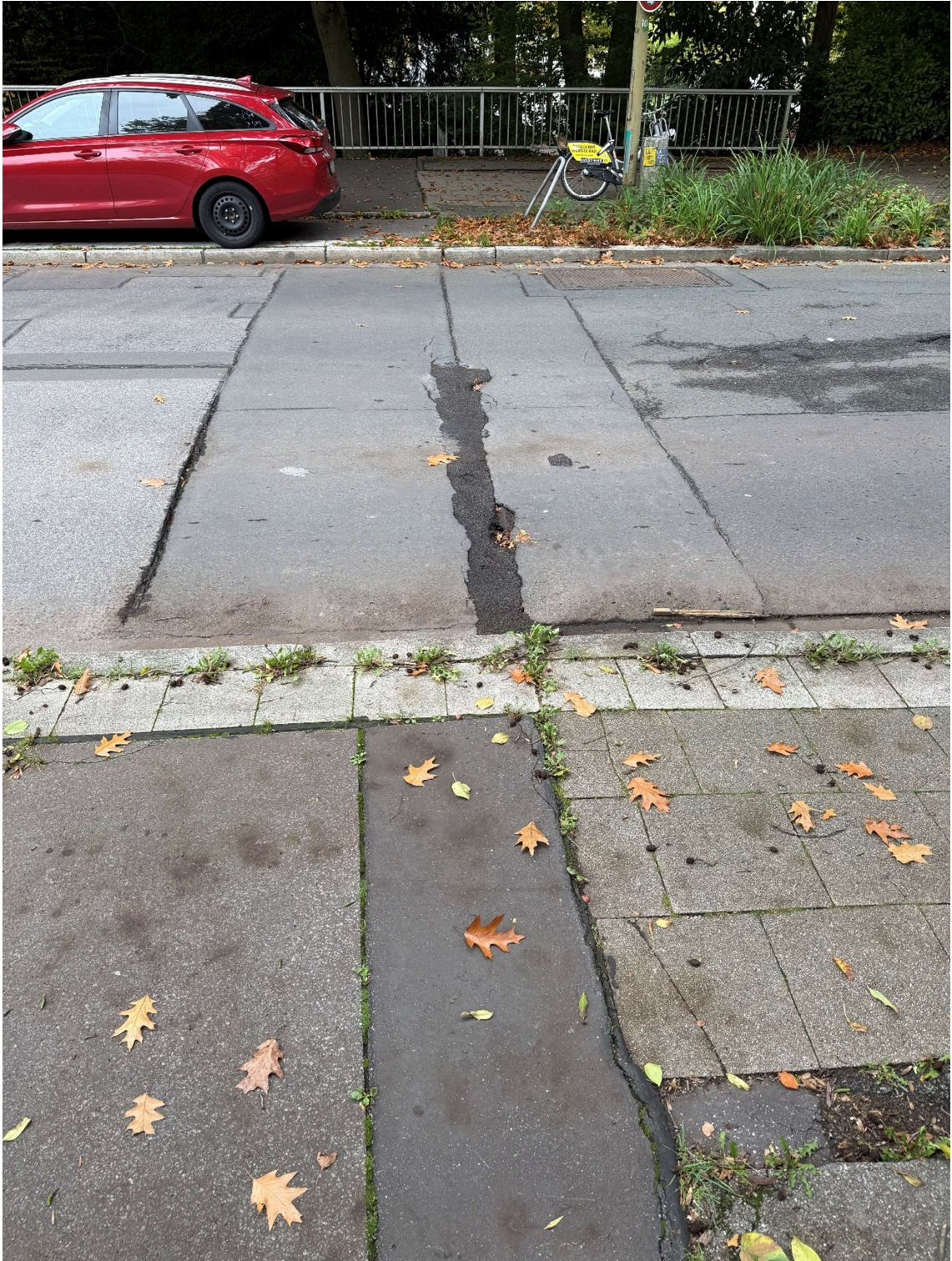
Abbildung 5: Oktober 2025 bereits beschädigter Kaltasphalt
